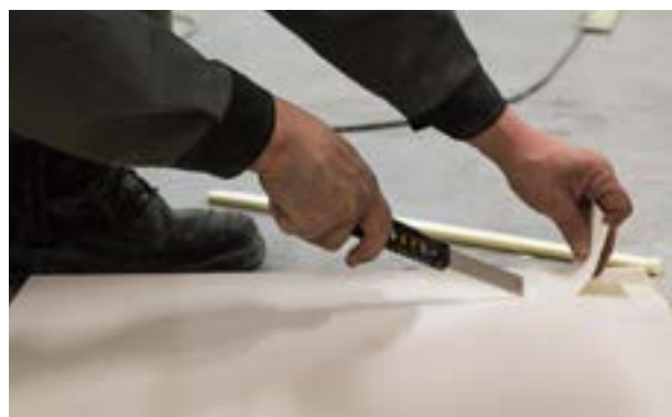
b) Usunięcie okładziny z części płyty łączącej się z czołem poprzeczną.
