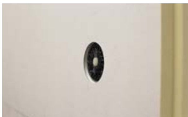
Zdjęcie nr 14. Widok zainstalowanego kołka.
