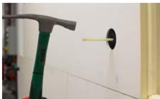
Etap IV d) Montaż trzpienia kołka.
