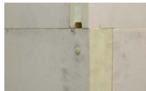
Zdjęcie nr 13. Widok zainstalowanego elementu zabezpieczającego narożnik.
