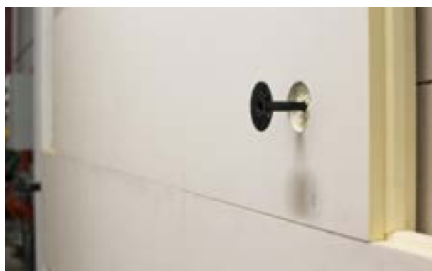
Etap IV b) Wykonanie zagłębienia w płycie pod koszulkę kołka.
