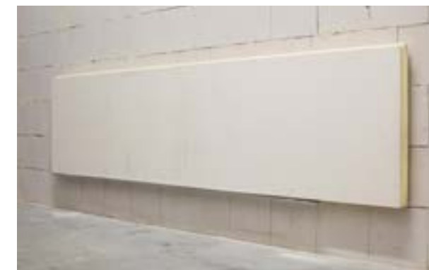
Zdjęcie nr 6. Widok na ustawione płyty.
