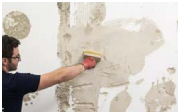
Etap II. Odpylenie podłoża.
