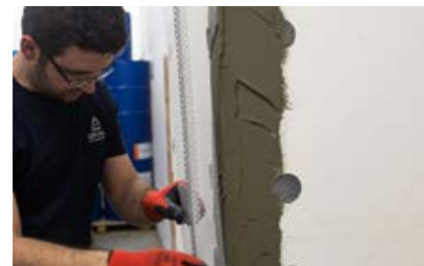
Etap V c) Montaż narożnika gotowego.
