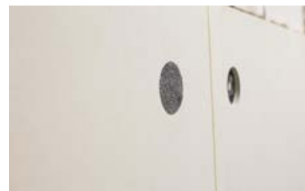
Zdjęcie nr 15. Widok zainstalowanej zatyczki.
