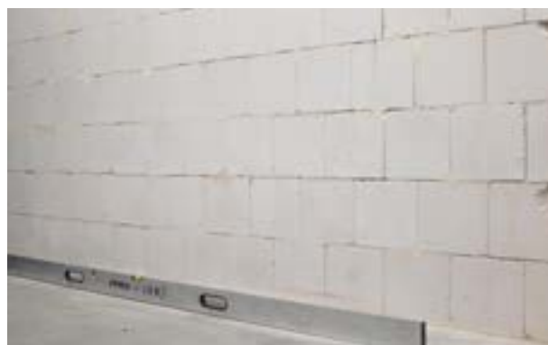
Etap I. a) Wyznaczenie położenia listwy startowej.
