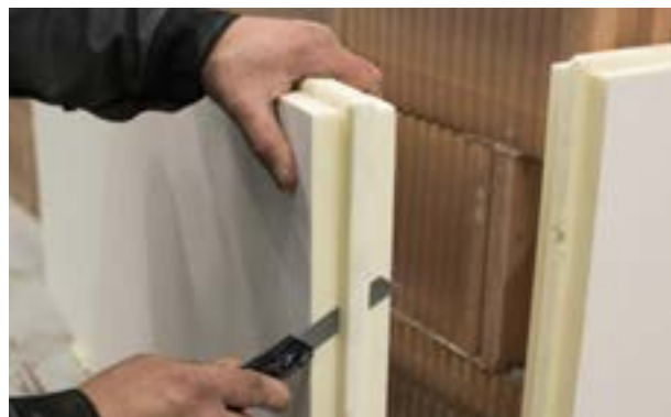
a) Ścięcie pióra zamka.
