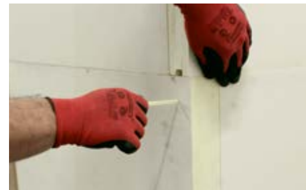
e) Instalacja łączników tworzywowych zabezpieczających narożnik przed deformacją.
