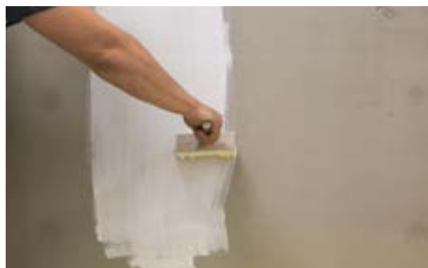
Etap VI a) Gruntowanie warstwy zbrojonej.
