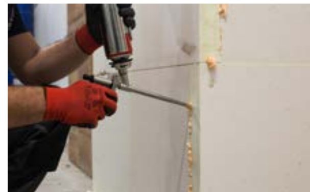
Etap V a) Wypełnienie szczelin niskoprężną pianą poliuretanową.
