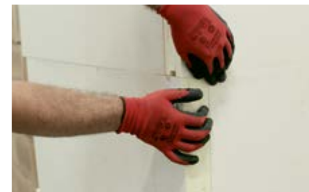
e) Instalacja łączników tworzywowych zabezpieczających narożnik przed deformacją.
