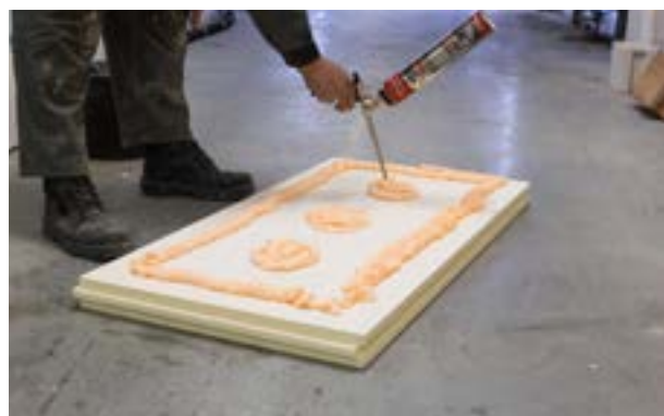
Zdjęcie nr 8. Ułożenie kleju poliuretanowego na płycie.
