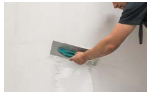
Etap VI b) Układanie warstwy wykończeniowej.
