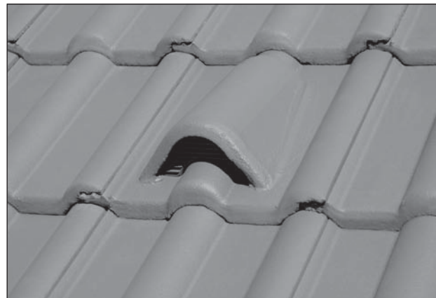
Detailní záběr na tašku větrací ve střeše
